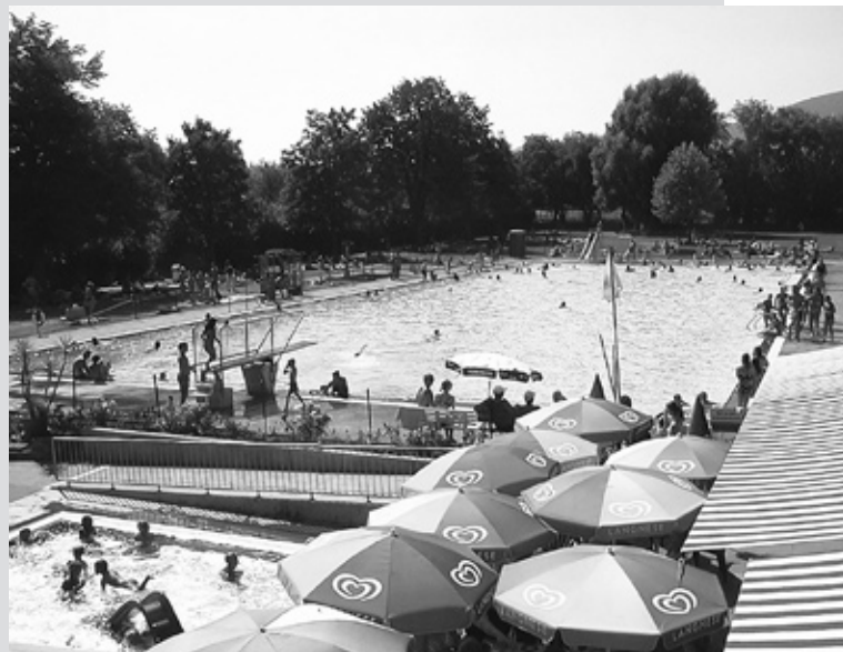
Freibad Edesheim vor der Sanierung
