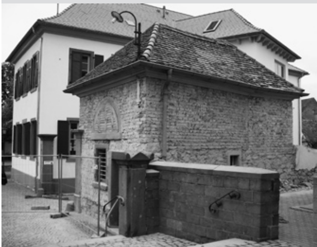
Während des Abrisses im September Fotos: C. Sternberger
